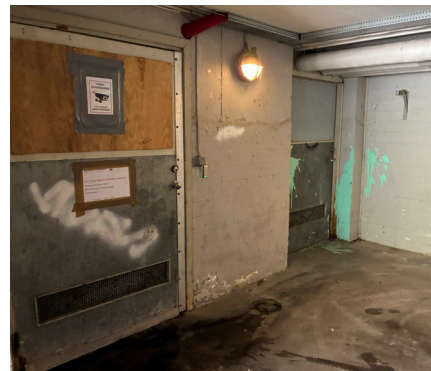
Foto fra kælderniveau med eksisterende døre
