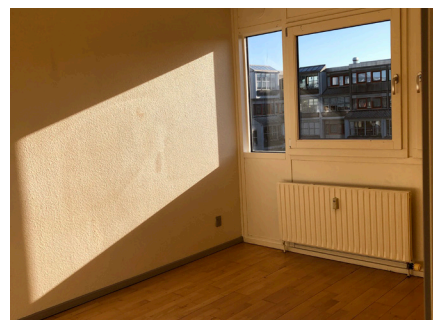
Foto af eksisterende trægulv
