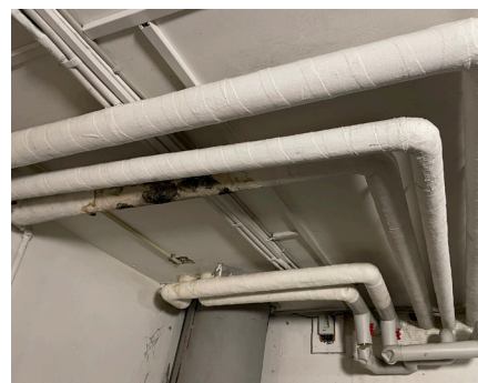
Foto af eksisterende installationer i kælder
