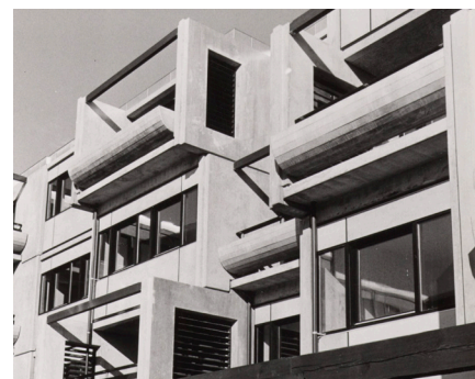
Foto fra bebyggelsens opførelse ca. 1972
